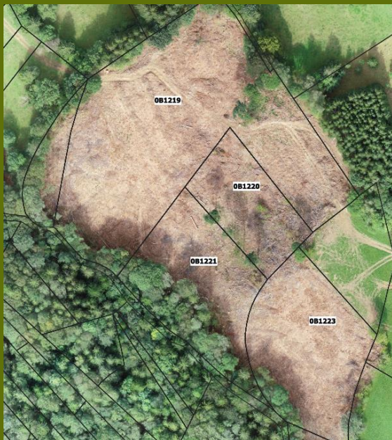
Suivi des chantiers d'exploitation
